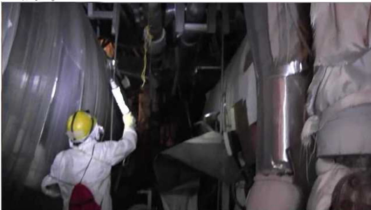
I C気相配管の目視確認状況：下側から照明を当てて遠くから眺めただけ
