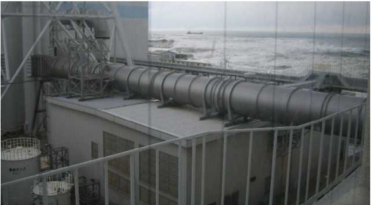
写真14 (写真11の0分52秒後)
