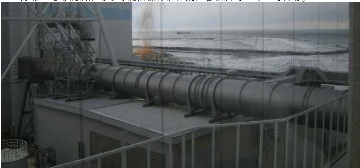
写真12 (写真11の0分04秒後)
