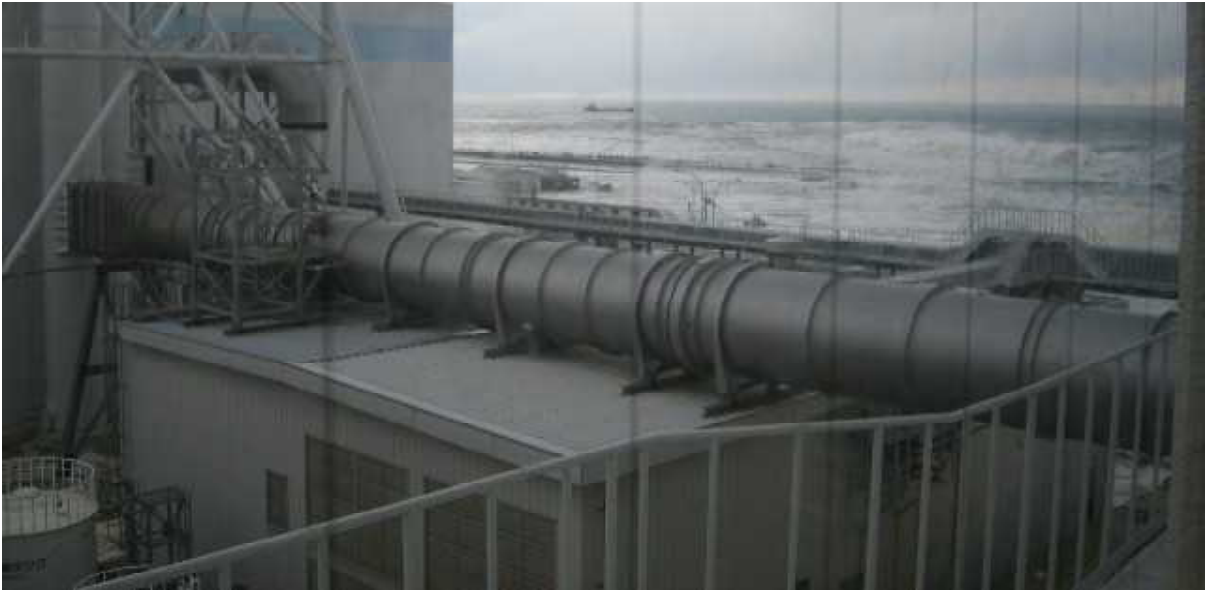
写真13 (写真11の0分37秒後)
