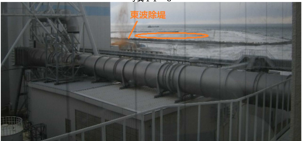
写真12-2 (写真11の0分04秒後)
