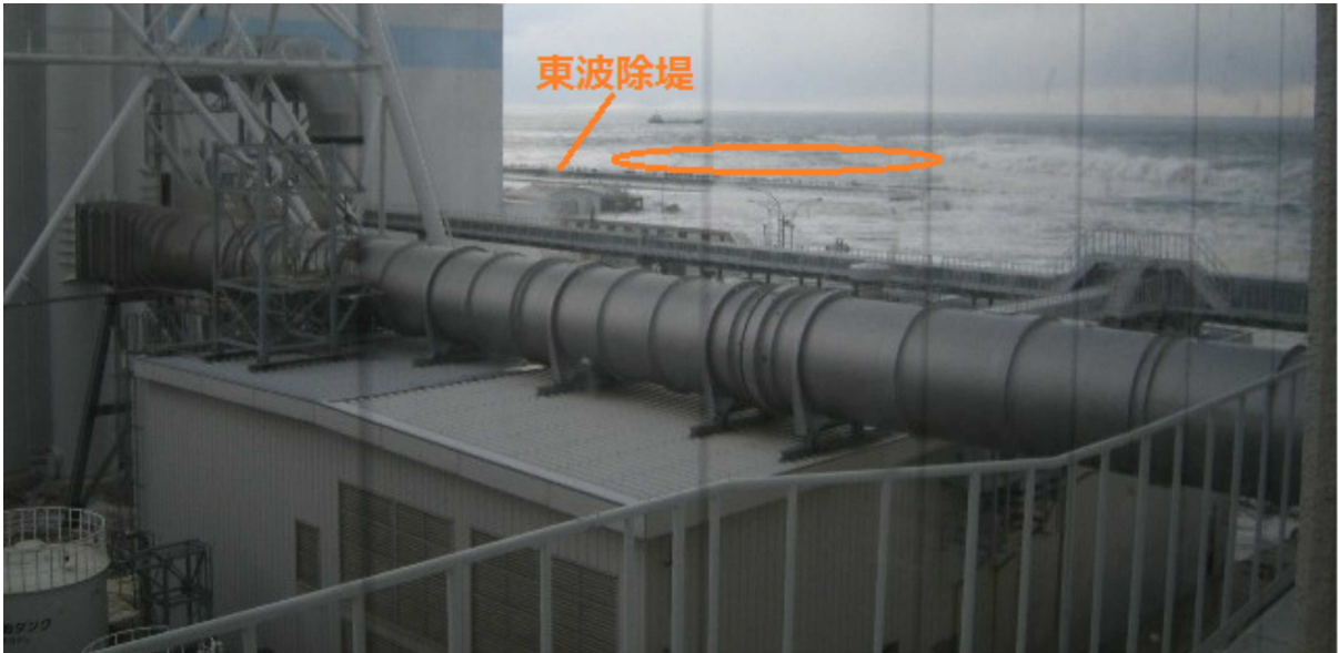
写真13-2 (写真11の0分37秒後)
