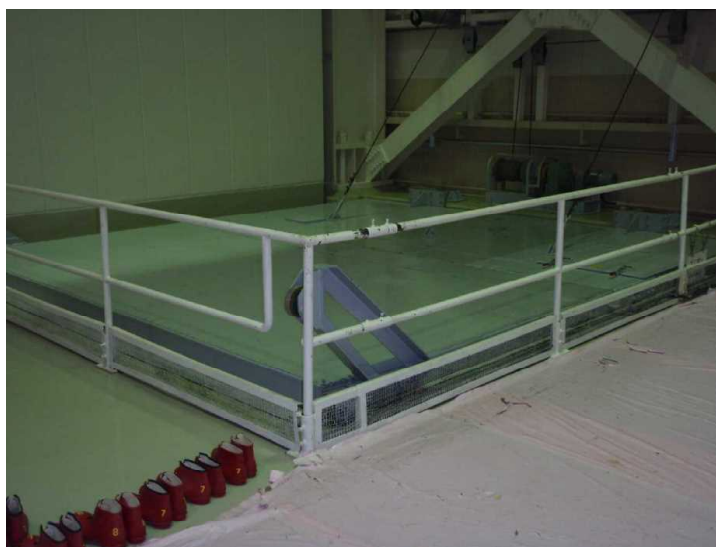
写真7 大物搬入口の蓋の形状（原子力規制庁出水現地調査報告書より）
